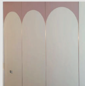
Соединение молдингов и краски в одну плоскость
