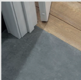
Соединение ламината и керамогранита без порожка
