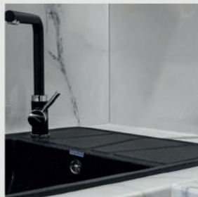
Стык столешницы и фартука без плинтуса
