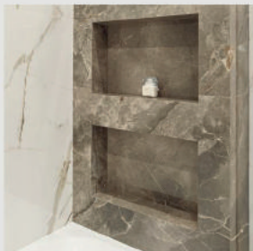
Монтаж полок из керамогранита и конструкций из плитки
