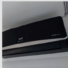
Монтаж сплит систем без кабель каналов
